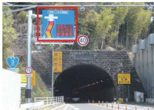
▲国道3号線武岡トンネル情報板
