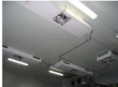
▲青果物用大型保冷库天井に加湿器4台取付
