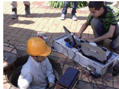
▲検査作業の様子
