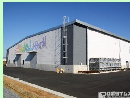
生活支援ロボット安全検証センター
