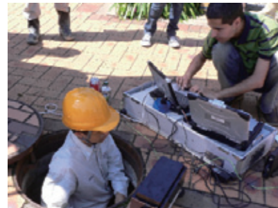
▲検査作業の様子
