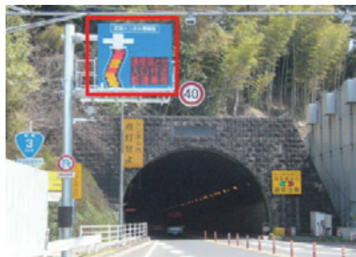
▲国道3号線武岡トンネル情報板
