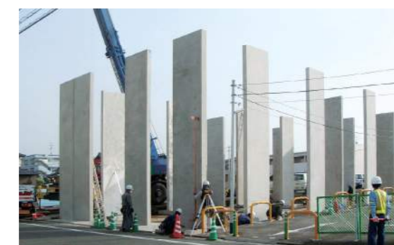
PCa 壁柱の設置施工
