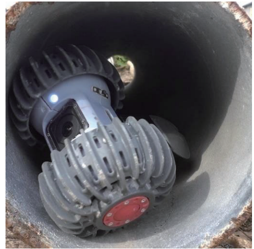
図. 管中の作業ロボット
