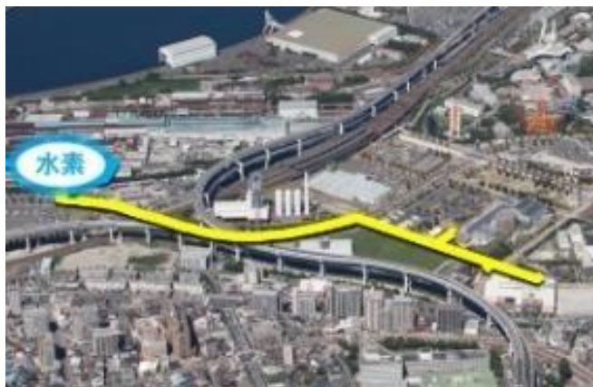
街中の水素パイプライン
