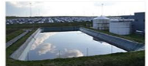
雨水の工業用水への利用 例) TMMF (フランス) の雨水貯槽
