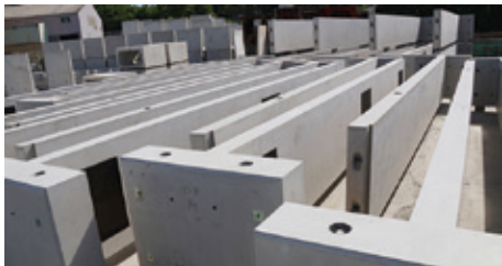
▲PCa製作状況
