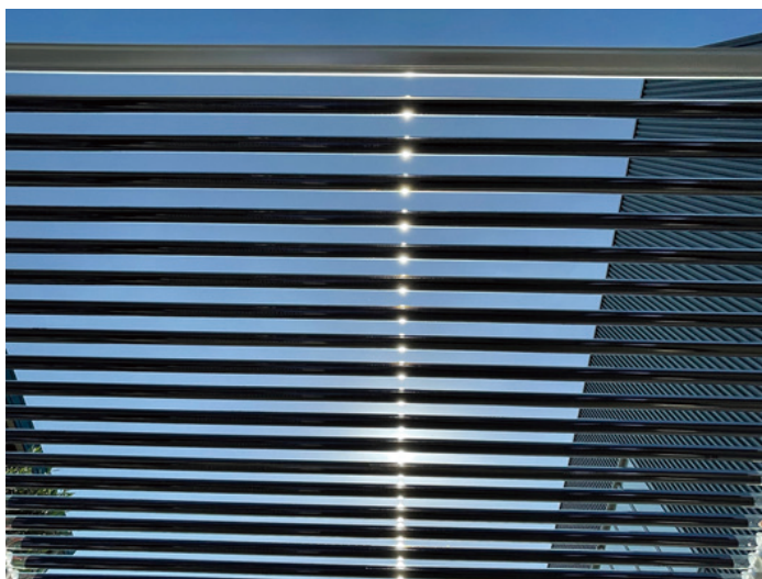
▲光と風が通過可能な円筒型太陽電池
