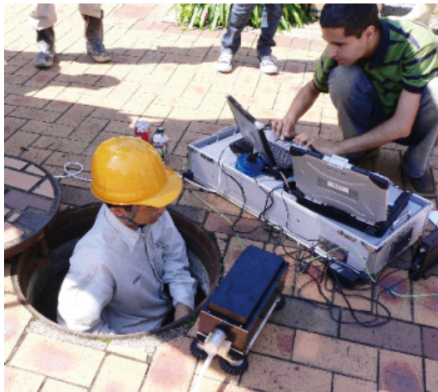
▲検査作業の様子
