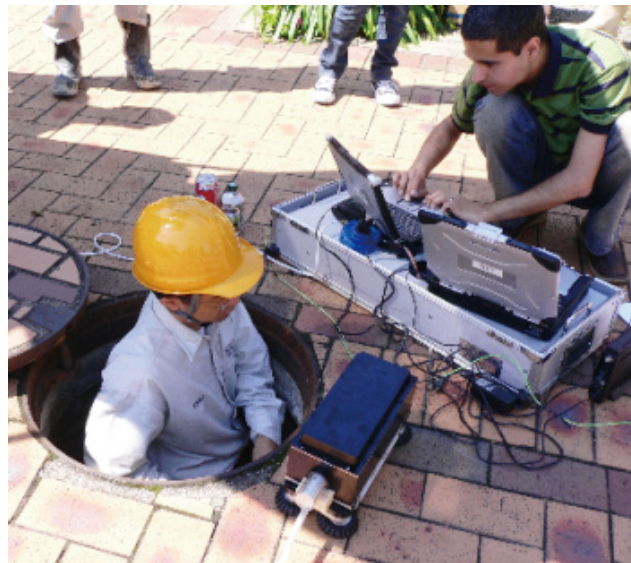
▲検査作業の様子
