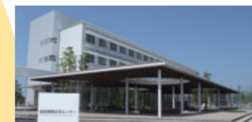
▲カーエレクトロニクス、ロボット事業の拠点となる技術開発交流センター
