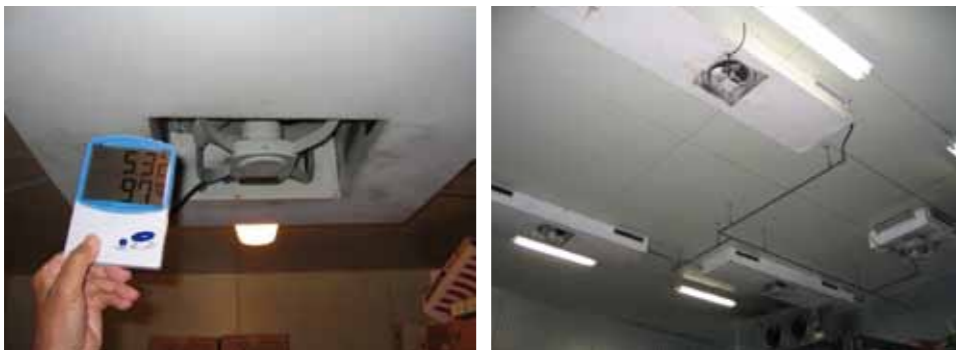
▲保冷库内温度5.3℃ 湿度97% ▲青果物用大型保冷库天井に加湿器4台取付
