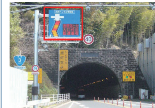
▲国道3号線岡岡トンネル情報板
