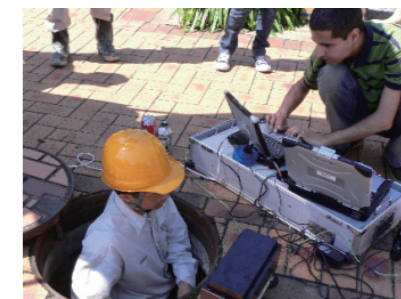
▲検査作業の様子
