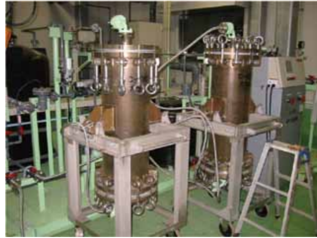
▼海水リチウム回収プラント(吸着カラム)
