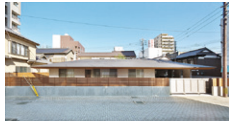
▲住宅施工例(竣工 全景)
