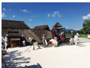
▲敷き均し作業
