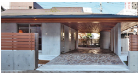
▲住宅施工例(竣工 PCa仕上がり近景)
