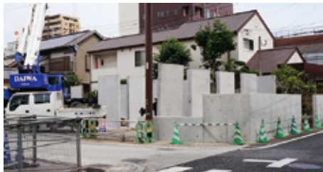
▲住宅施工例(PCaの設置状況)
