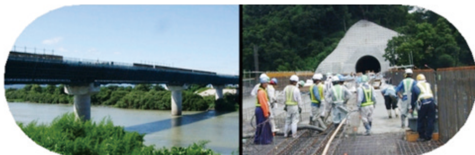
▲北陸新幹線橋梁
