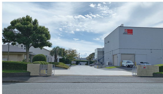
真空機器工場 正門より
