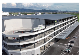
NX鳥栖 ロジスティクスセンター（外観）
