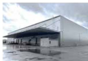
NX熊本 ロジスティクスセンター（外観）
