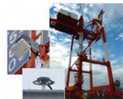
改造を行ったガントリークレーンと機器
